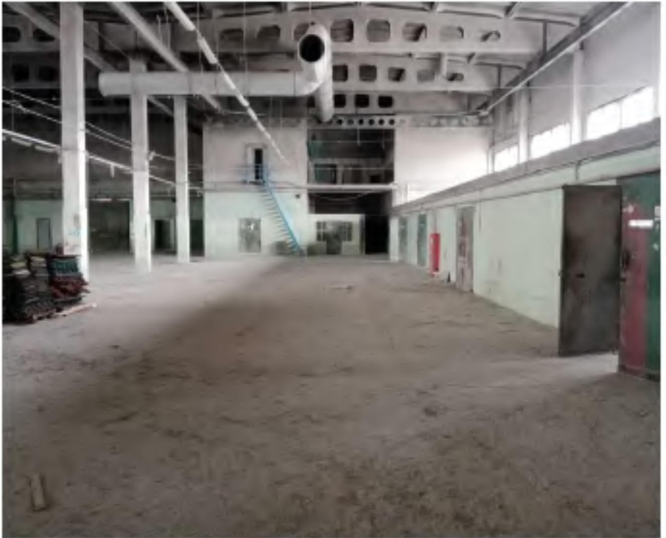
Фото 1. Часть изолированного помещения (ремонтной мастерской)
