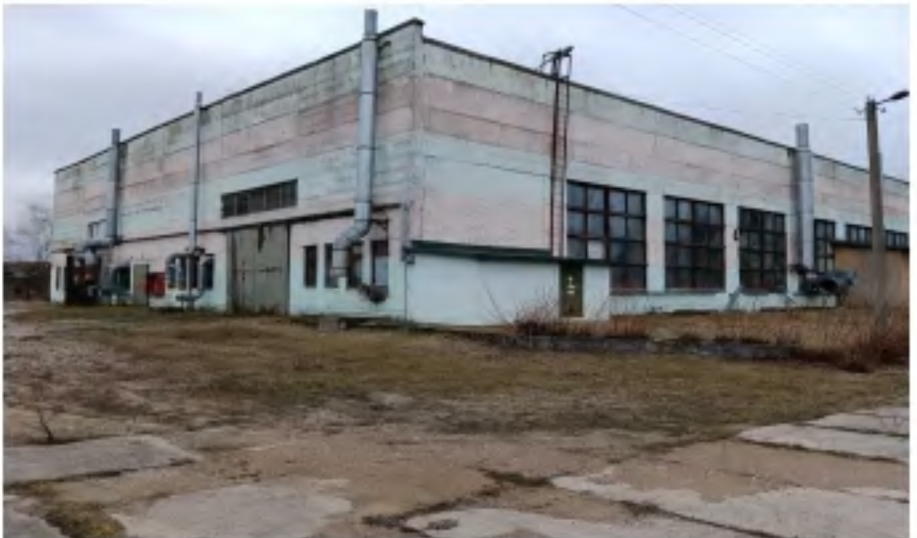
Фото 1.3 Вид с наружи части изолированного помещения (ремонтной мастерской)
