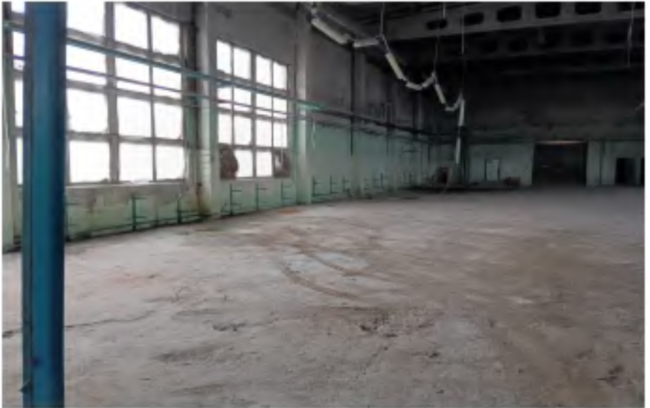
Фото 1.4 Часть изолированного помещения (ремонтной мастерской)
