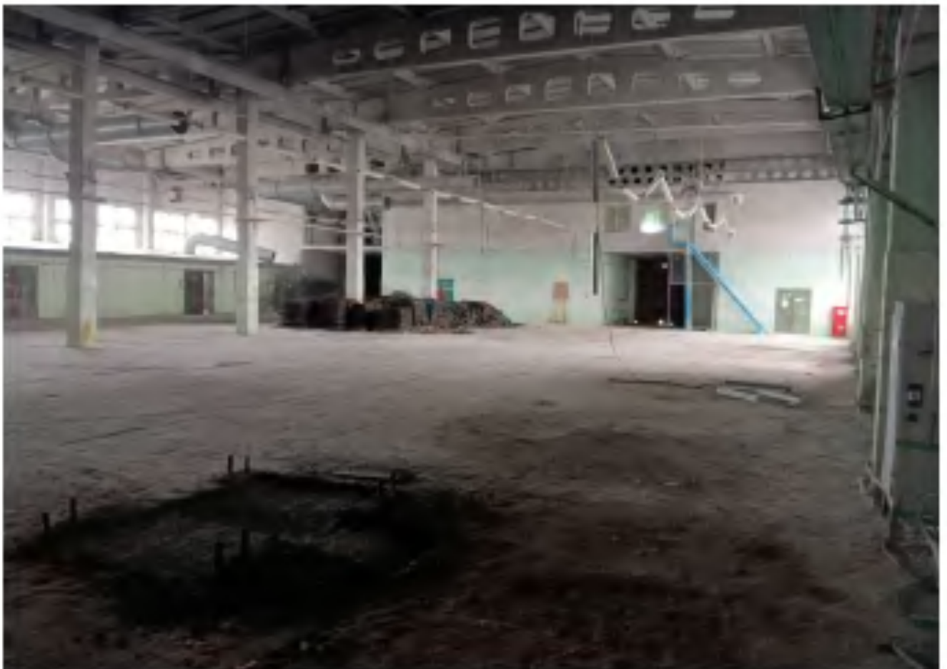
Фото 1.5 Часть изолированного помещения (ремонтной мастерской)
